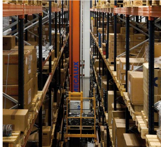
Figura 4. Transelevador Unit load de Mecalux
