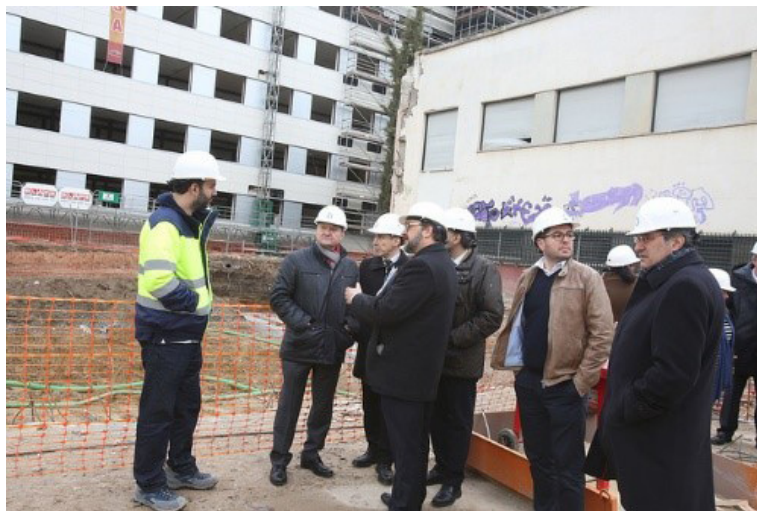
El rector, a pie de obra, recibe explicaciones del responsable de la Unidad Técnica de Arquitectura de la UVa, Francisco Valbuena, a cerca del proceso de rehabilitación de la Sede Doctor Mergelina, futuro Edificio de Grados de la EII. - Foto: Departamento de Comunicación de la UVa.
