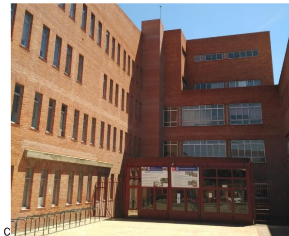
Figura 40. Fotografía fachada EII
