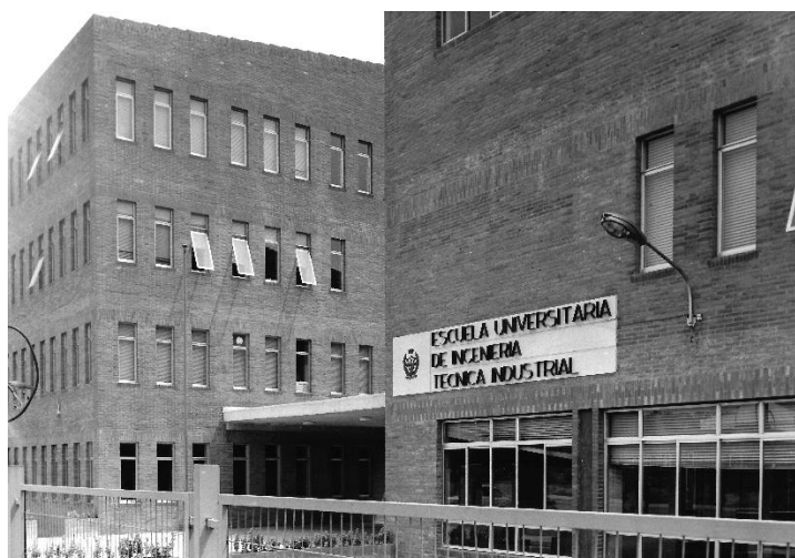
Imagen 29: Fachada principal de la E.U.P.
