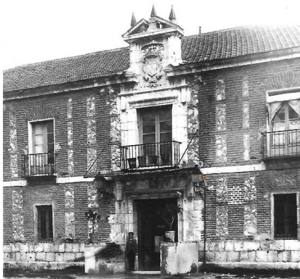
Imagen 27: Fachada principal del Colegio Mayor de Santa Cruz
