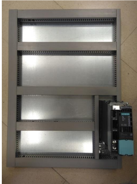
Figura 18: Montaje del variador en placa.
