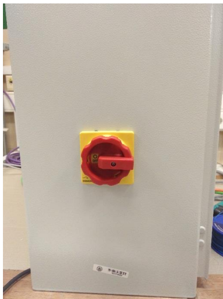
Figura 25: Seccionador general.
