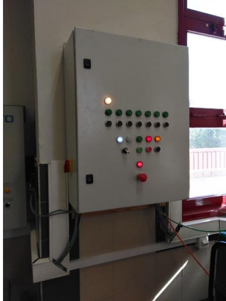
Figura 38: Vista exterior de cuadro colgado.
