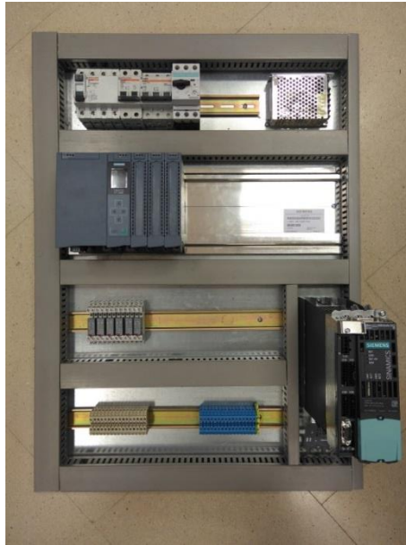
Figura 24: Montaje de bornero.
