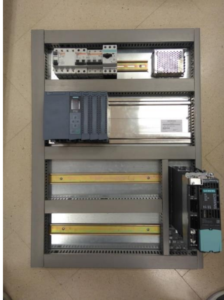
Figura 22: Montaje equipos de protección y mando.
