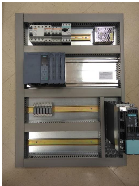
Figura 23: Montaje de relés.
