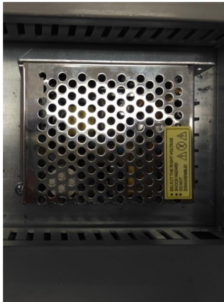
Figura 20: montaje de fuente de alimentación auxiliar.
