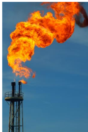
Figura 11. Antorcha de quemado de biogás en el vertedero.
