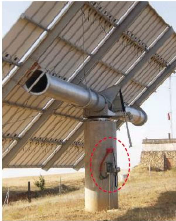
Imagen 17. Caja de conexiones de un panel fotovoltaico.
