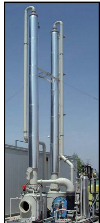
Ilustración 13: Instalación de una columna de gas stripping
