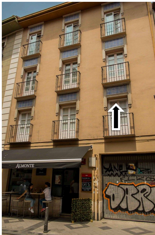
Fig. 65.: Imagen de la fachada del nº 3 de la Calle San Martín. Se ha señalado con una flecha los mosaicos sobre los balcones.
