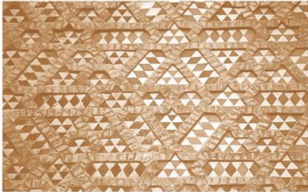
Fig. 73.: Paño de la zona central del muro de la Parroquieta. Ejemplo de mosaico de tipo p3 en la ciudad de Zaragoza.
