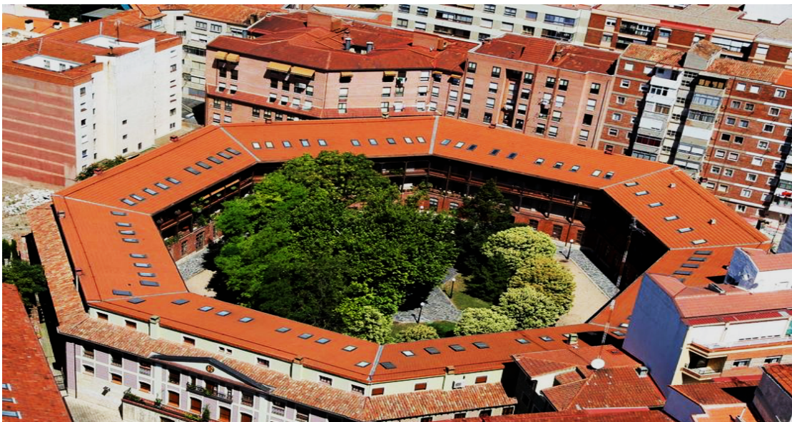
Fig. 54.: Vista aérea de la plaza interior del Viejo Coso, la primera plaza de toros construida en Valladolid y reconvertida ahora en pisos de viviendas.
