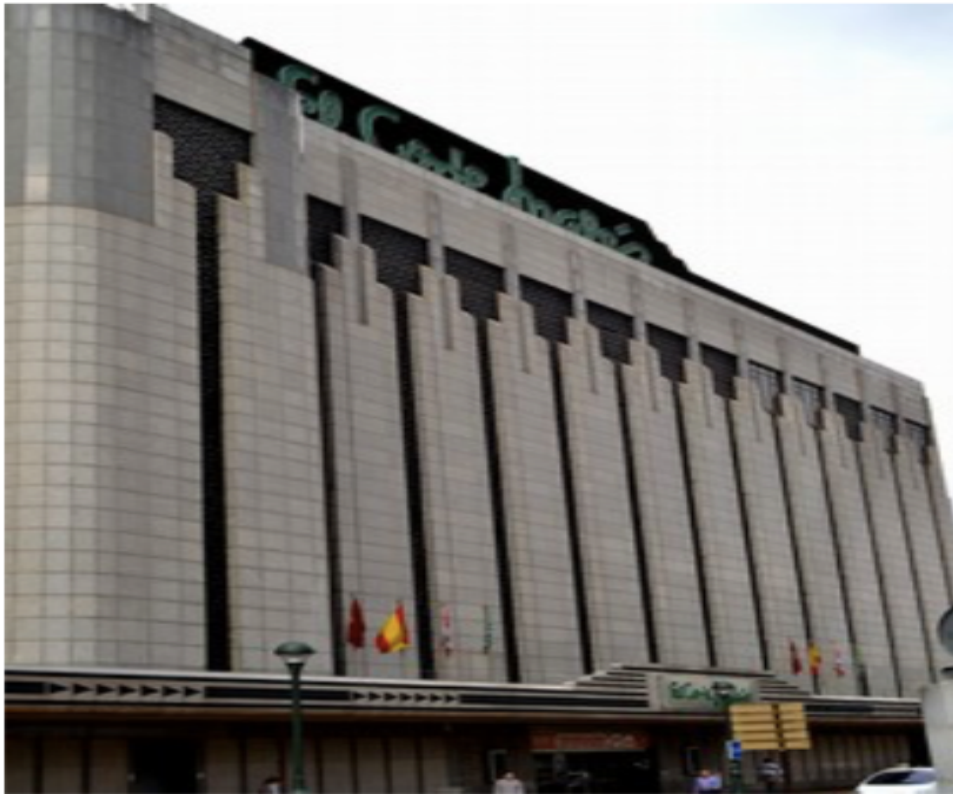
Fig. 50.: Fachada del edificio de El Corte Inglés donde encontramos nuestro ejemplo de mosaico más sencillo, el GSE-2D p1.
