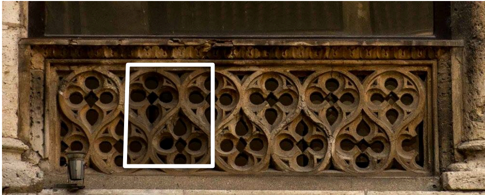
Fig. 60.: Baranda en piedra del primer piso del claustro del Convento de las Francesas y que resulta ser un GSE-2D de tipo pmg. Se ha marcado la celdilla unidad.
