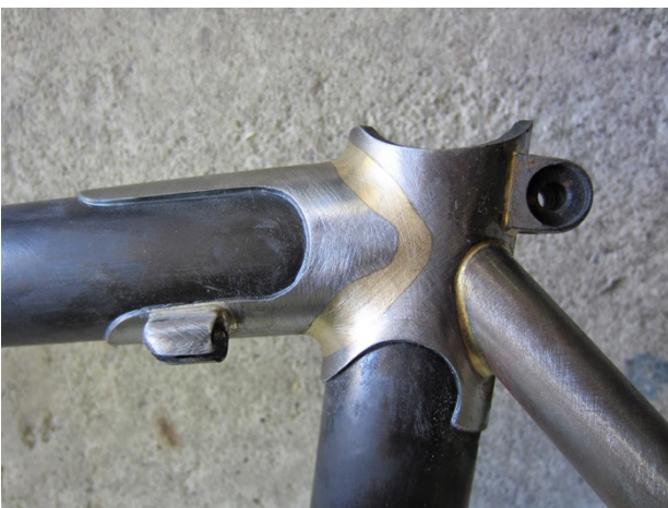
Ilustración 72: uniones una vez soldadas.
