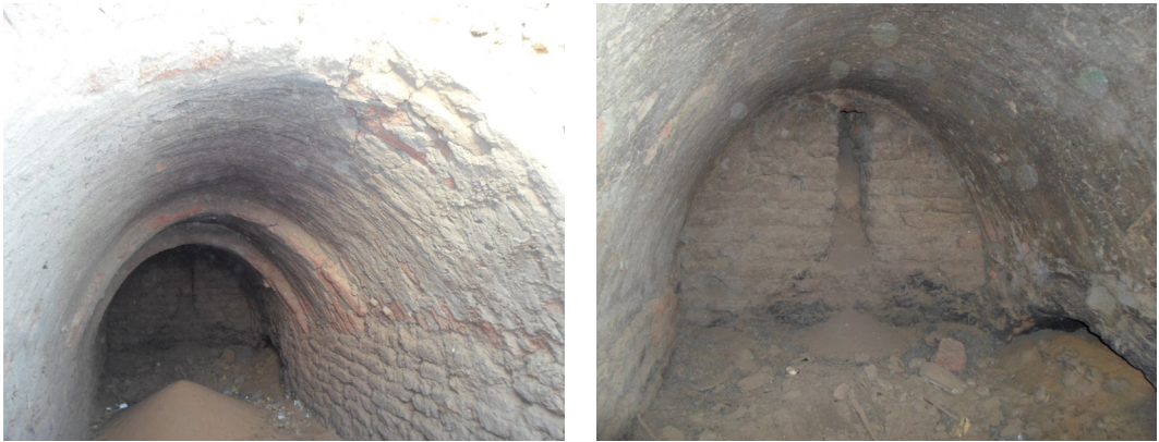
Figura 2a/2b. Edificios abandonados, semienterrados por la arena del desierto, construidos con bóveda Nubia de adobe, Soleb (Sudán). Fuente: F. Jové.
