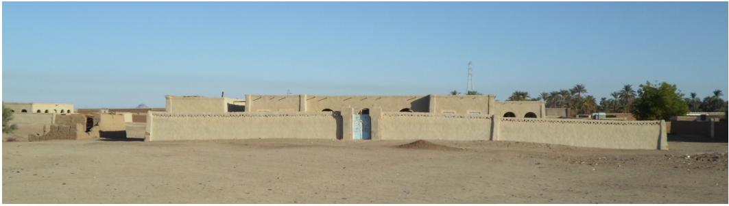
Figura 9. Vivienda tradicional en la orilla oeste del río Nilo, Dongola (Sudán). Fuente: F. Jové.
