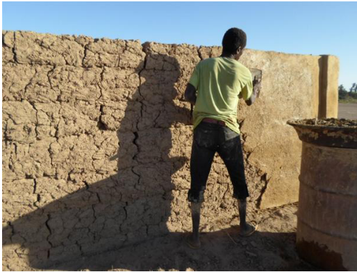
Figura 5a/5b. Barreado artesano sobre un muro de tierra cortada en Dongola (Sudán) Fuente: F. Jové.
