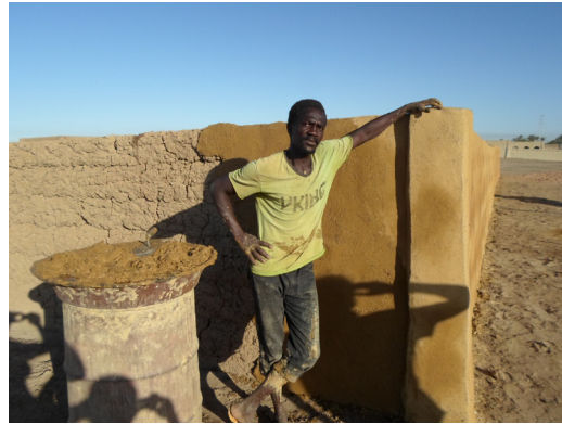
Figura 5a/5b. Barreado artesano sobre un muro de tierra cortada en Dongola (Sudán) Fuente: F. Jové.
