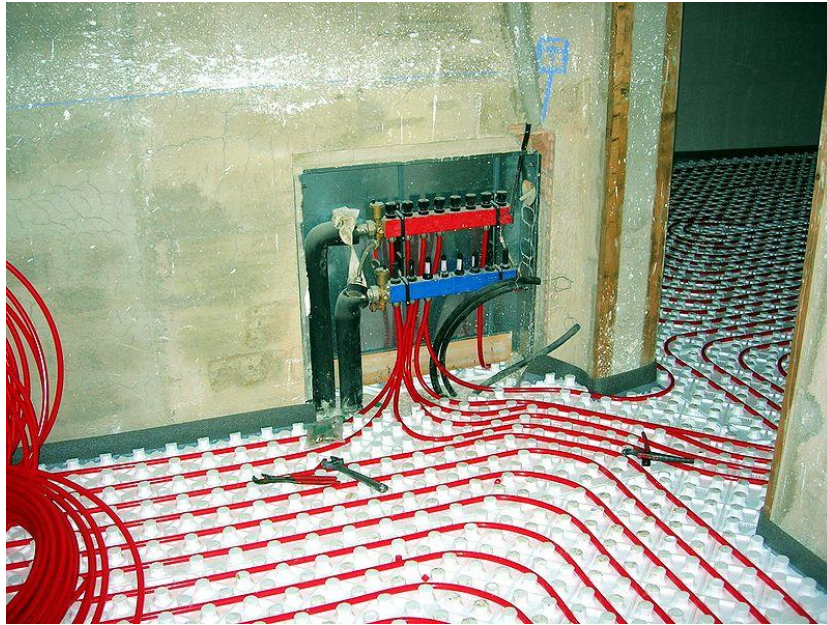
Figura 25. Suelo radiante por agua caliente.
