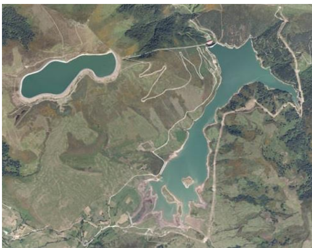
Figura 4.2.1.2. Vista aérea de los embalses de Alsa (derecha) y de Mediajo (izquierda).
