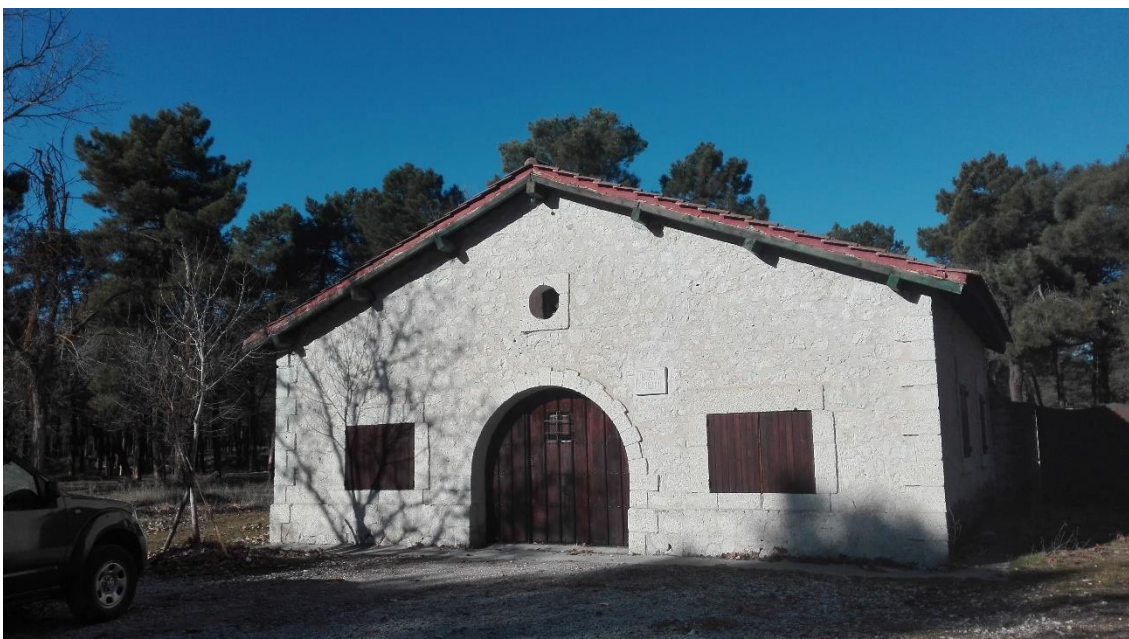
Figura 2. Fotografía Antigua Casa Forestal, actualmente Refugio.
