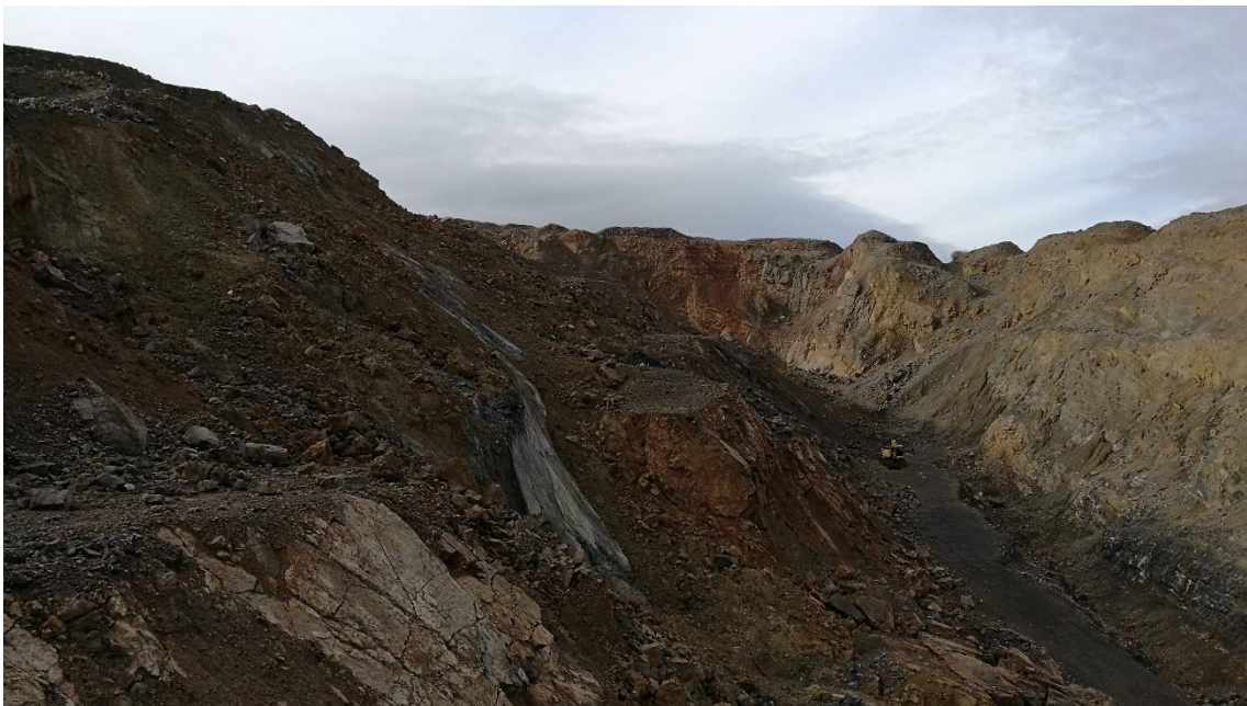
Imagen 2. Hueco minero (visto desde arriba de los taludes).
