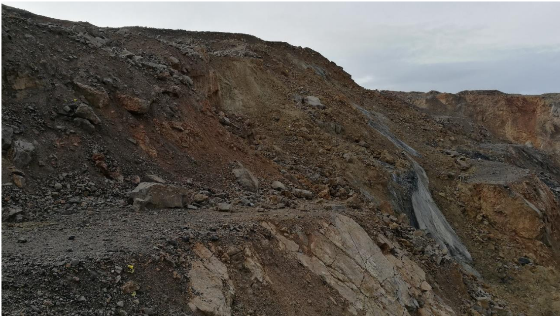
Imagen 5. Talud izquierdo (banqueado).
