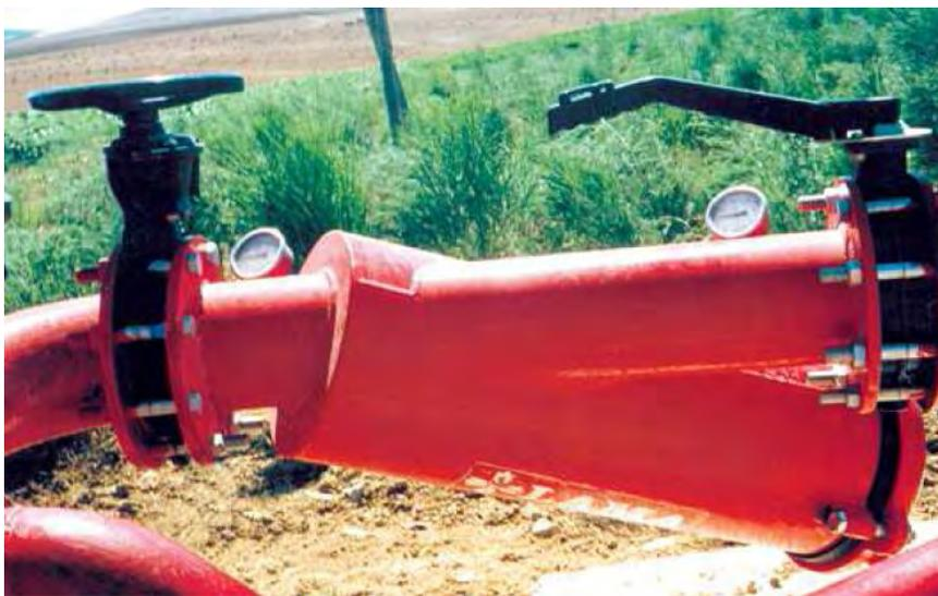
Figura . Válvula de compuerta a la izquierda y válvula de mariposa a la derecha de un filtro para el control del caudal.
