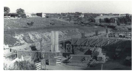
[3.34] Inicio de la construcción de la losa.
