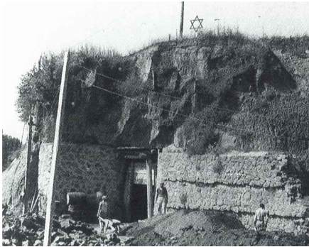
[3.22] Trabajos de consolidación en el acceso a las galerías.
