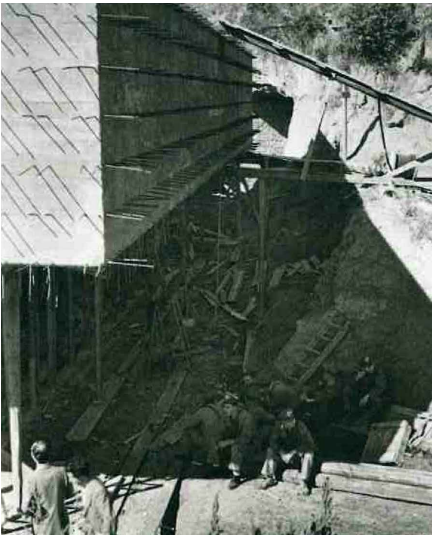
[3.46] Ejecución del acabado de la losa.
