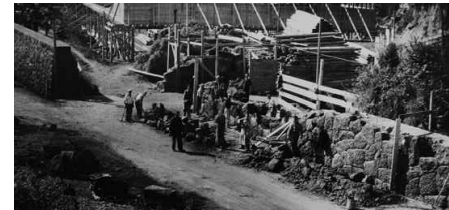
[3.35] Construcción de la muralla perimetral.
