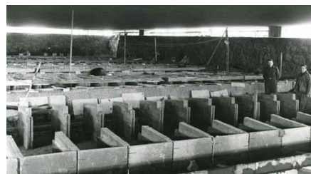
[3.60] Ejecución de los sarcófagos.
