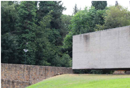
[3.20] Vista de la losa y del muro perimetral desde la plaza.
