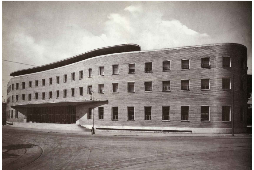
[3.6] Palazzo delle Poste de Mario Ridolfi construido entre 1933 y 1935 en la Plaza Bologna de Roma.
