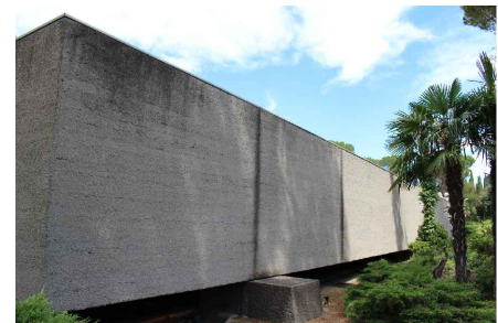
[3.79] Uno de los seis apoyos de la losa.
