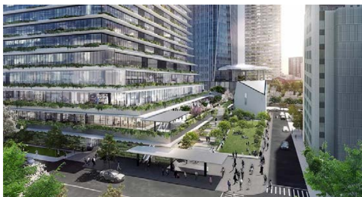
Fig. 5.4 Rascacielos eco amigables: la torre de negocios Toranomon Hills en Tokio (Japón) sufrirá una transformación de inclusión de vegetación, en la dirección de la arquitectura sostenible. Véase anexo 1.
