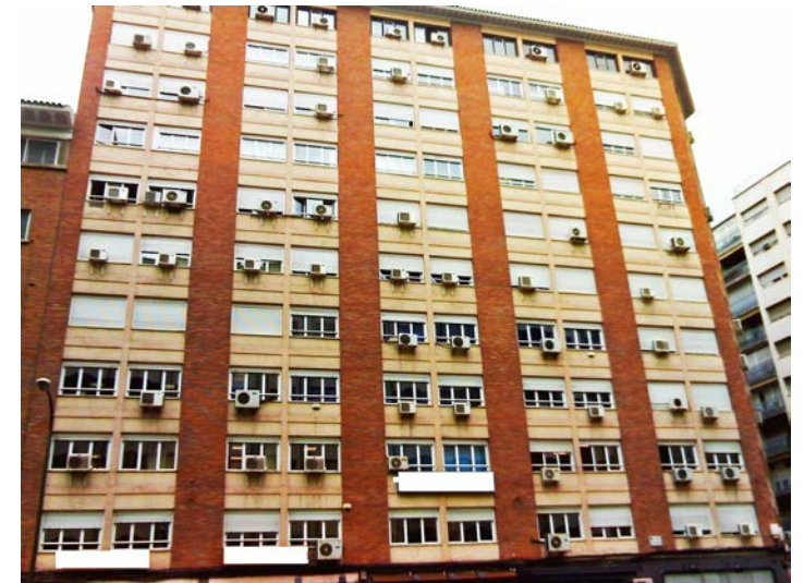
Fig. 2.10 Fachada de un bloque de viviendas infectada por aparatos de aire acondicionado, en Zaragoza (España). Las unidades condensadoras emiten mucho calor. Véase anexo 1.
