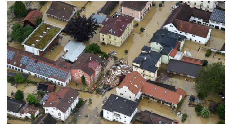
Fig. 2.11 Inundaciones en junio de 2016 en Simbach (Alemania). Con la presencia de pavimentos impermeables, el agua circula a sus anchas por las calles, arrastrando lo que encuentra a su paso. Véase anexo 1.
