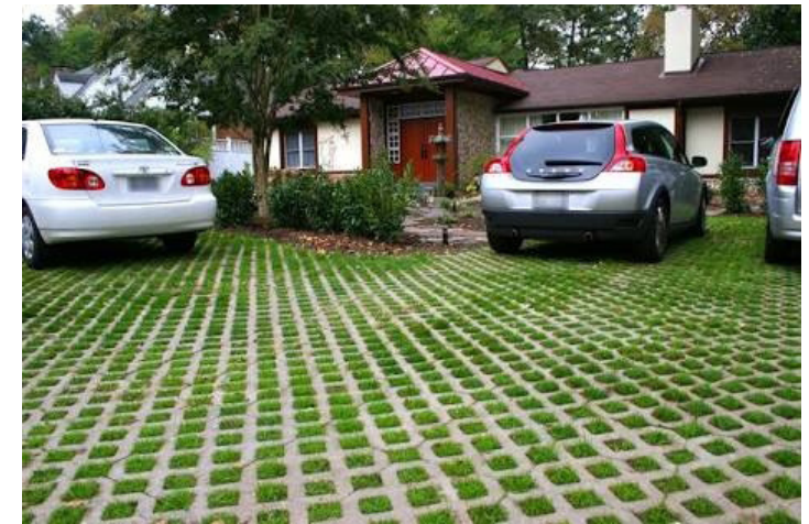
Fig. 5.37 Utilizar piezas prefabricadas agujereadas permite la permeabilidad al agua y el crecimiento de herbáceas. Véase anexo 1.
