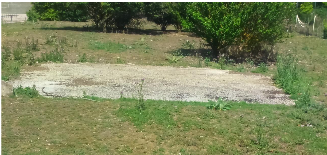
Figura 32. Plataforma de piedra y cemento que cubre depósito de gasolina en zona 2_d.
