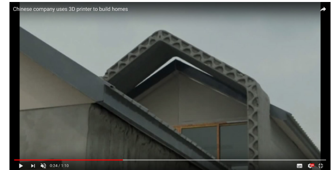
Vídeo de la empresa "Winsun New Materials" en el que explica y muestra cual es el proceso constructivo que lleva a cabo mediante su impresora 3d para elaborar una casa
