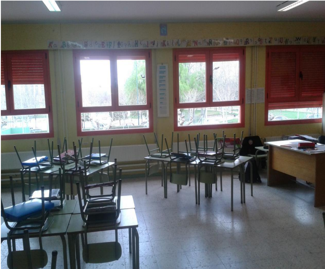
Figura 4: Imagen de la zona de ventanas del aula.
