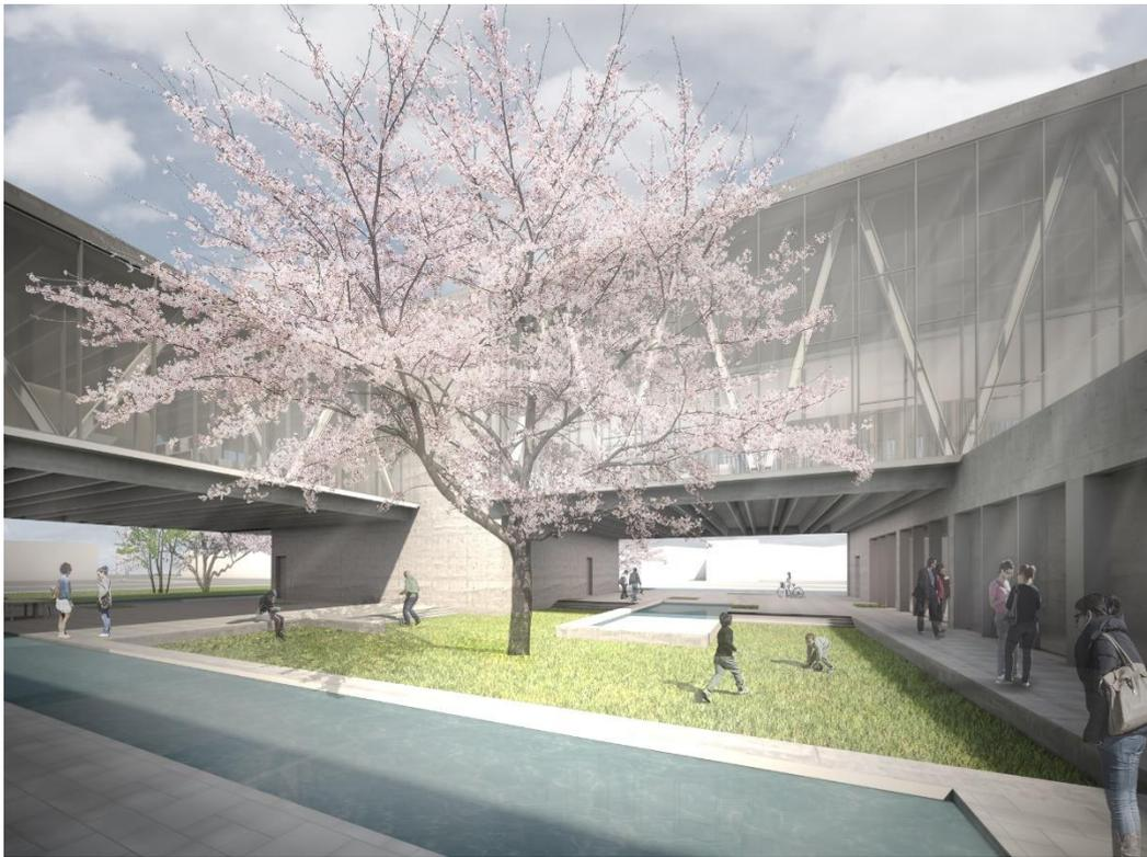
Sobre el volumen de coworking, que sube una planta más, se encuentra colgada a través de un sistema tensor de las esbeltas vigas de hormigón armado, una caja transparente que alberga la zona de administración y la sala polivalente, conectada además directamente con la zona de coworking a través de una larga rampa que recorre prácticamente toda la fachada.
