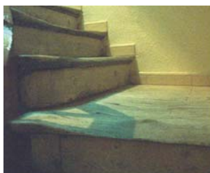
En la fotografía se puede observar como la elección de madera de baja calidad y con nudos ha producido el desgaste diferencial de las huellas del peldaño.
