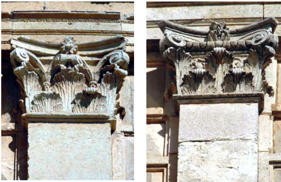
Fig. 6. Capiteles de orden corintio y compuesto en la fachada principal. Juan de Rozadilla. 1597. Iglesia de la Asunción. Lantadilla.
