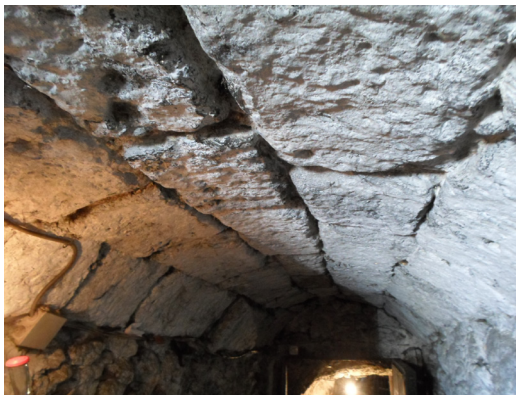
Fig. 3. Peñafiel. Cañón de acceso a la bodega. Fuente: F. Jové.
