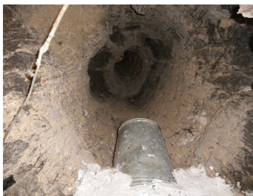
Fig. 8. Bodega la Pólvara, Peñafiel. Boca de un respiradero o chimenea de ventilación en la bóveda de la nave, a veinte metros de profundidad. Fuente: Félix Jové.
