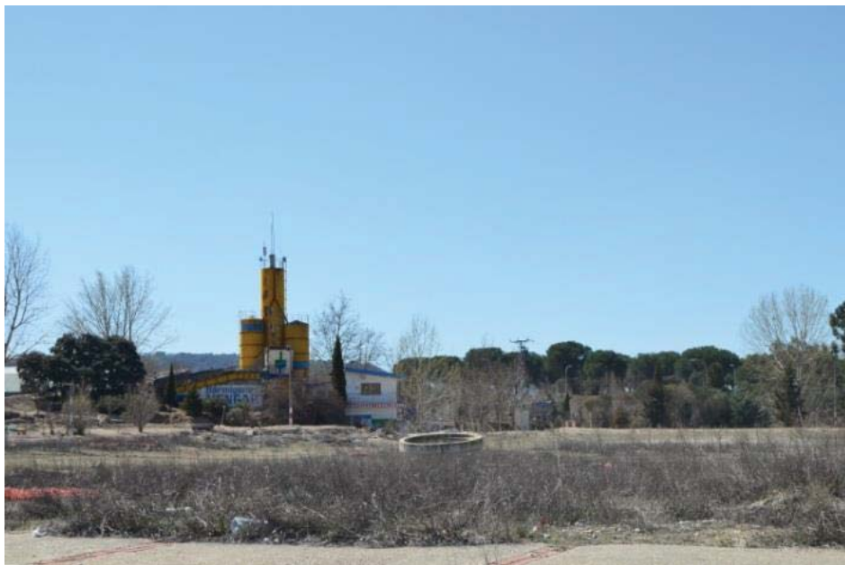
Figura 22: Hormigones Mengar en el polígono Tuduro
