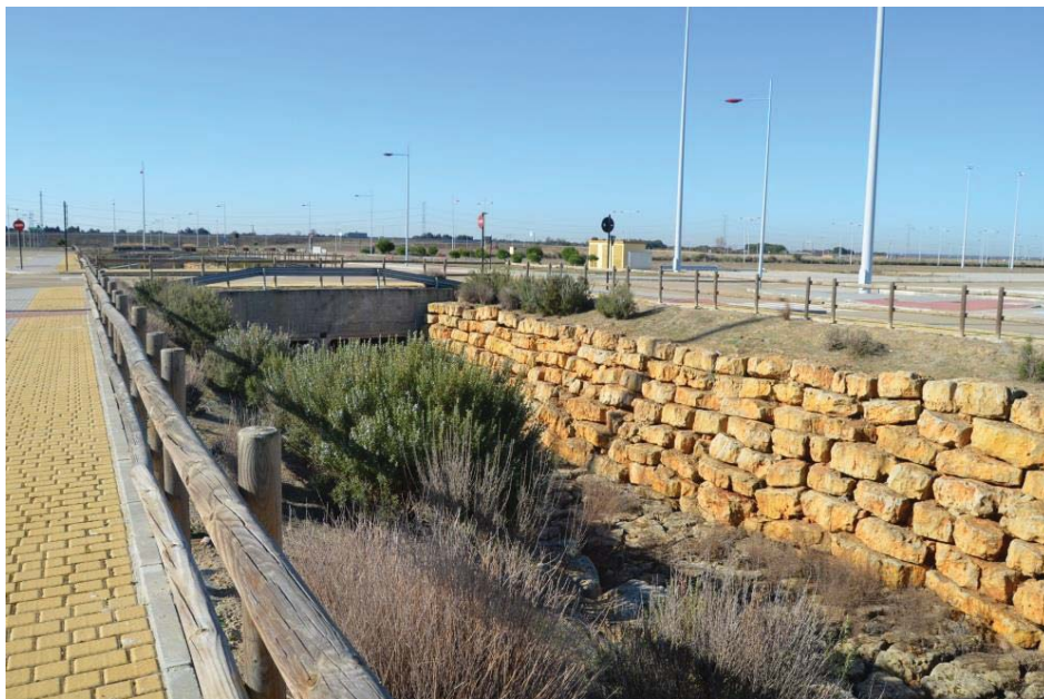
Figura 27: Arroyo de Callones en el polígono SEPES.
