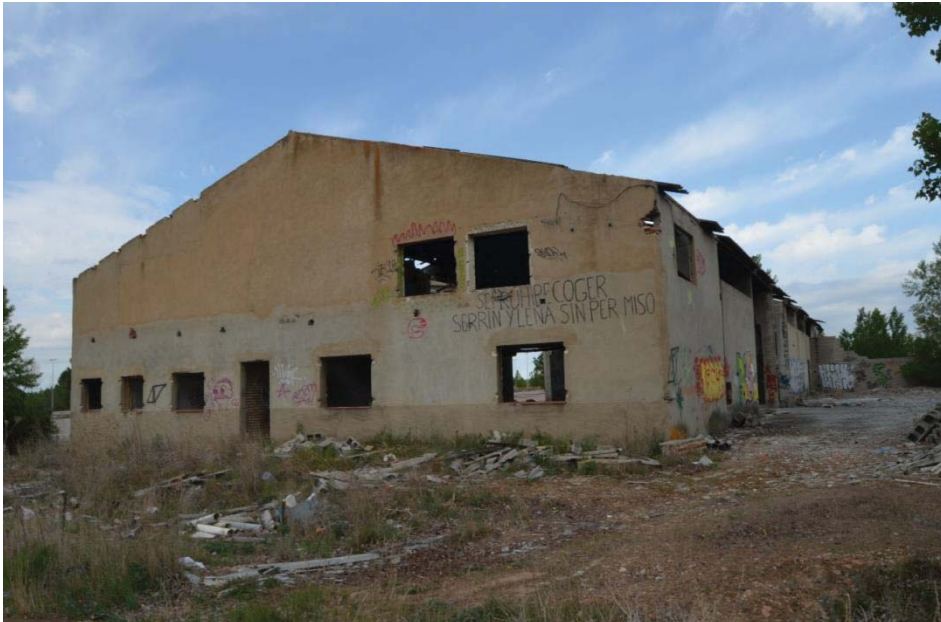
Figura 18: Nave en ruinas en el polígono Sector 3 Los Alamares
