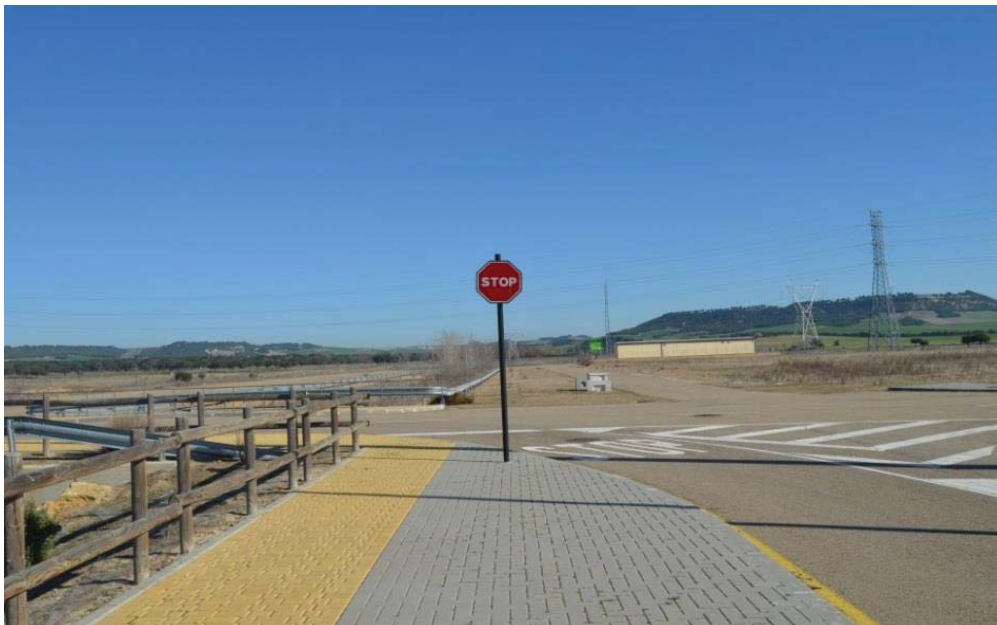
Figura 31: Calle del polígono SEPES
