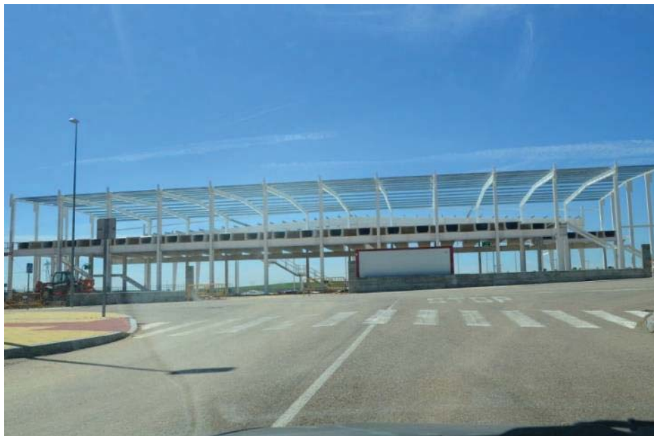
Figura 11: Nave en construcción en el polígono La Encomienda
