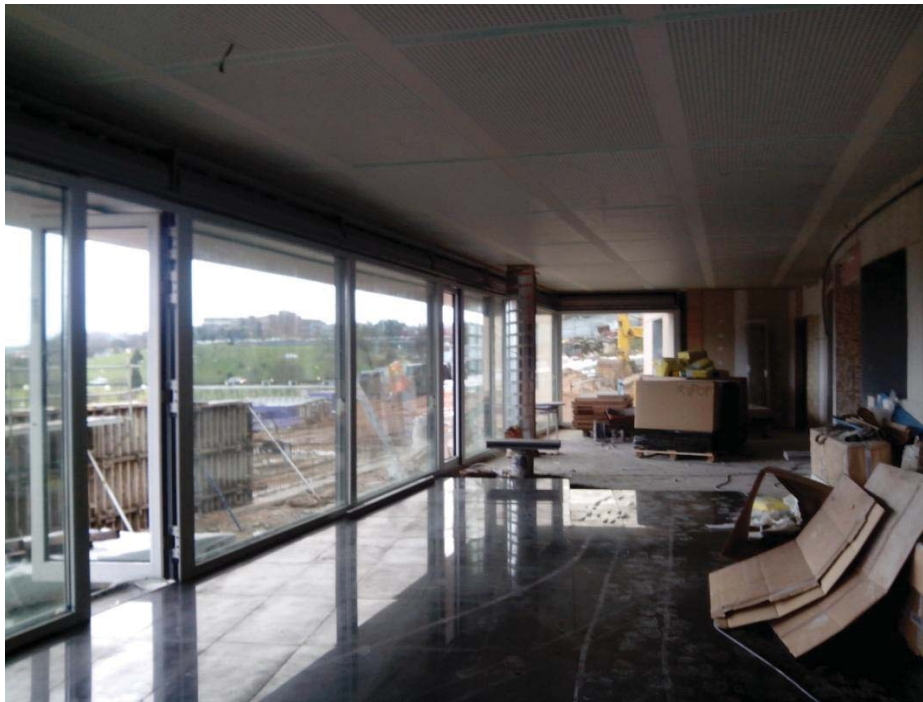
Ilustración 25 Interior del Museo Universidad de Navarra en construcción 76
