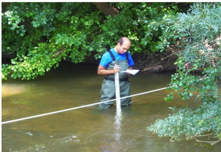
**Figura 20. Medición de la sección batimétrica del tramo 4 del estudio**
