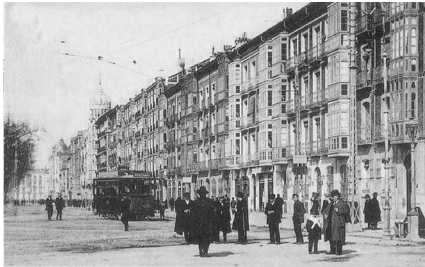
El Paseo que unió la Estación de Ferrocarril con el Centro de la Ciudad: la Acera de Recoletos
