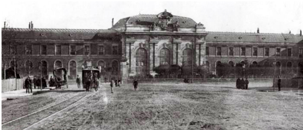
Estación de Valladolid a principios del Siglo XX. (AMVA)
