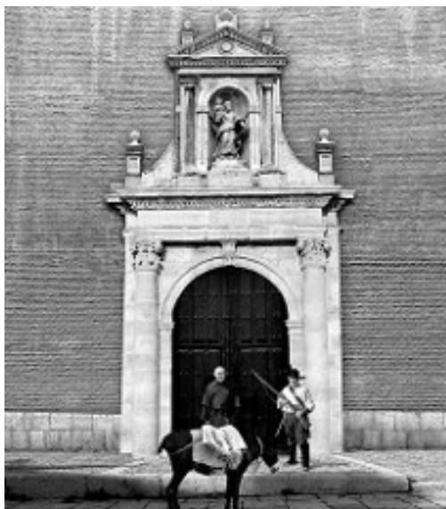
Reconstrucción aproximada de la portada de la Iglesia de San Gabriel, cuya parte inferior sirve hoy de puerta al Cementerio del Carmen. (Rincones con Fantasma, Uruña Paredes)
