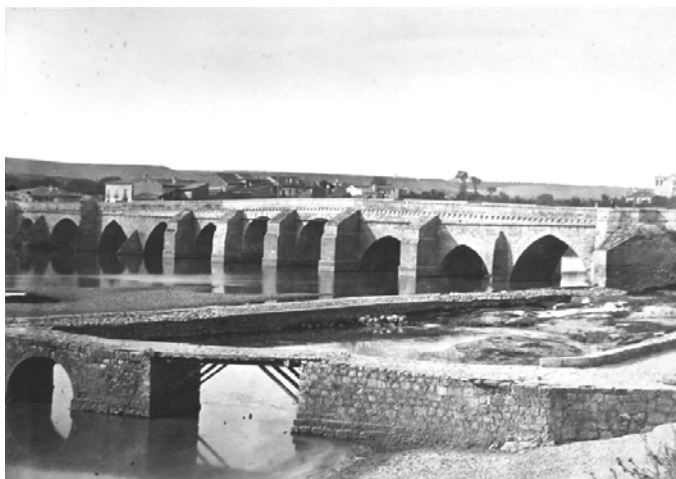
Puente Mayor de Valladolid
