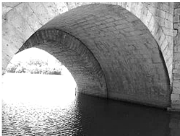
Imagen de uno de los ojos del Puente Mayor, en el que se aprecia la duplicación
