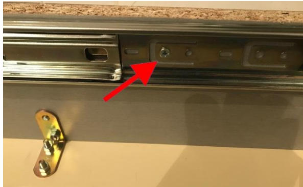
Figura 46. Detalle de la unión entre los carriles prismáticos y las paredes.
