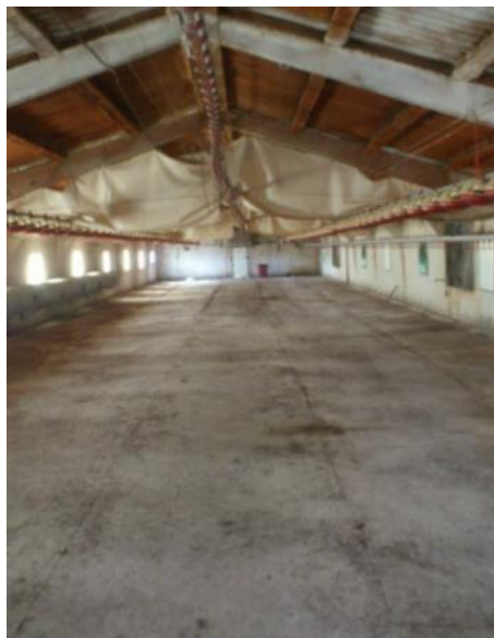
Figura 6. Interior de la nave, que será utilizada como gallinero.
