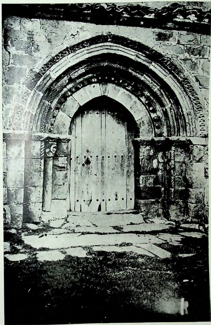
LÁMINA II.—Santa María de Villacantid. Puerta.
