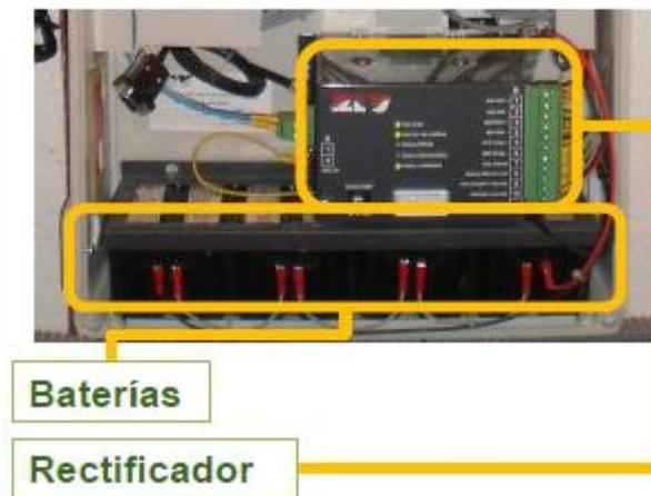
Figura 42. Rectificador de baterías dentro de un armario STAR.
