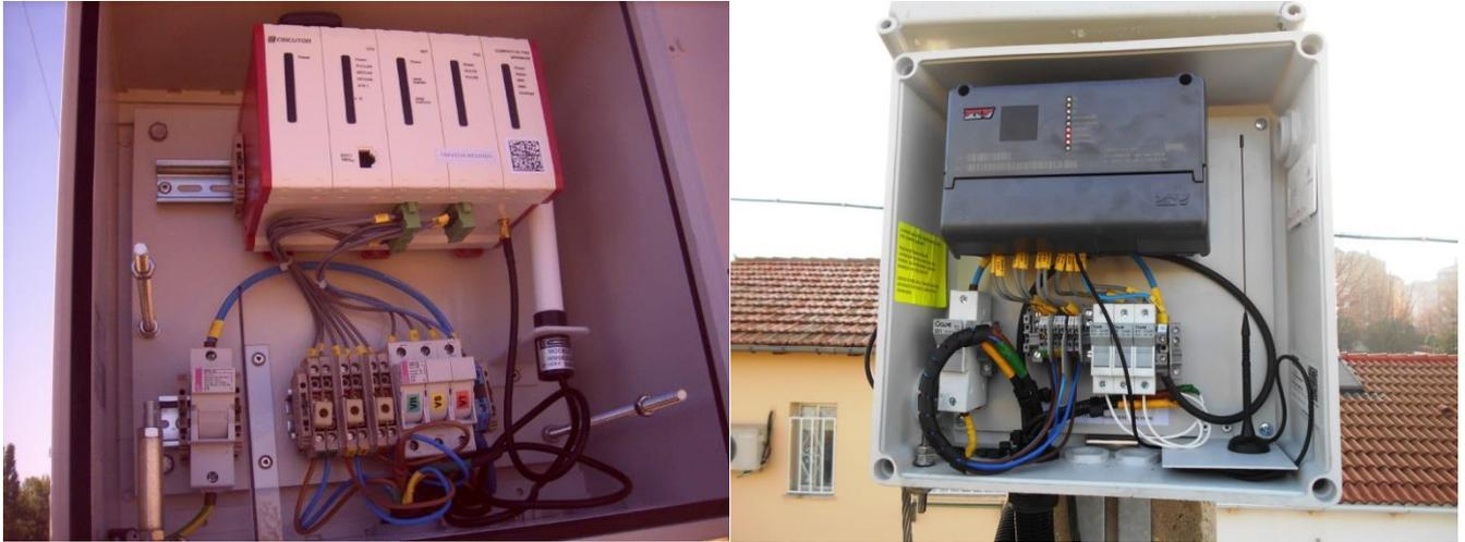
Figura 38. Ejemplo de dos equipos TGB de las marcas Circutor y ZIV, respectivamente.
