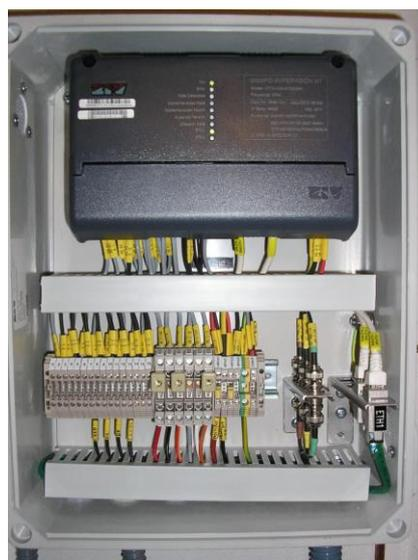
Figura 41. Remota dentro de un armario STAR.
