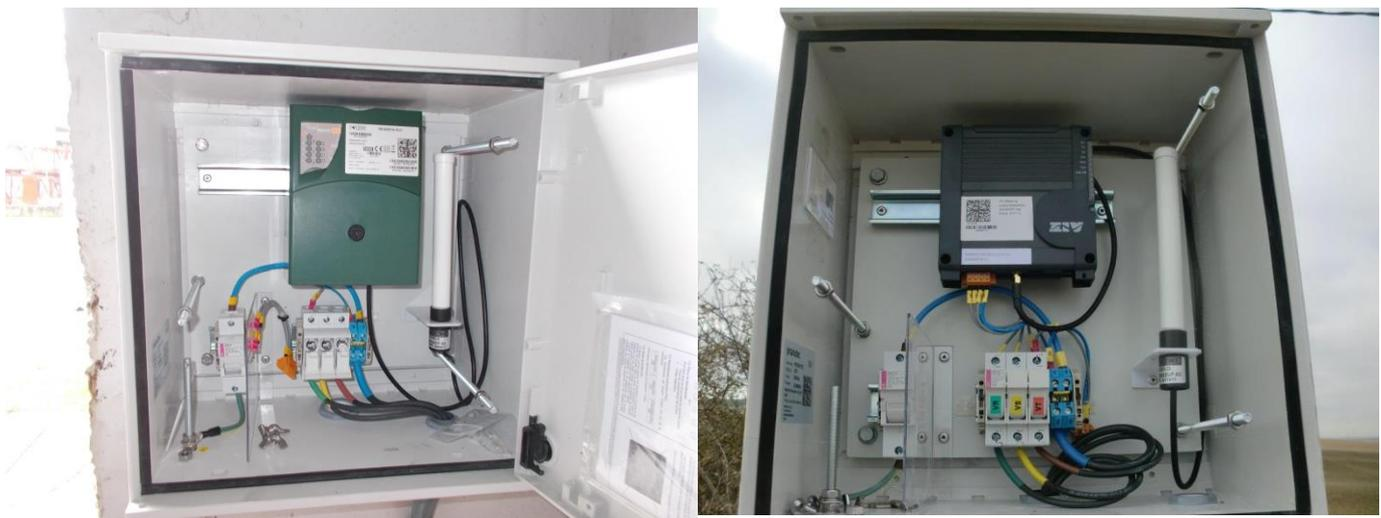
Figura 39. Ejemplo de dos equipos GTP de las marcas Teldat y ZIV, respectivamente.
