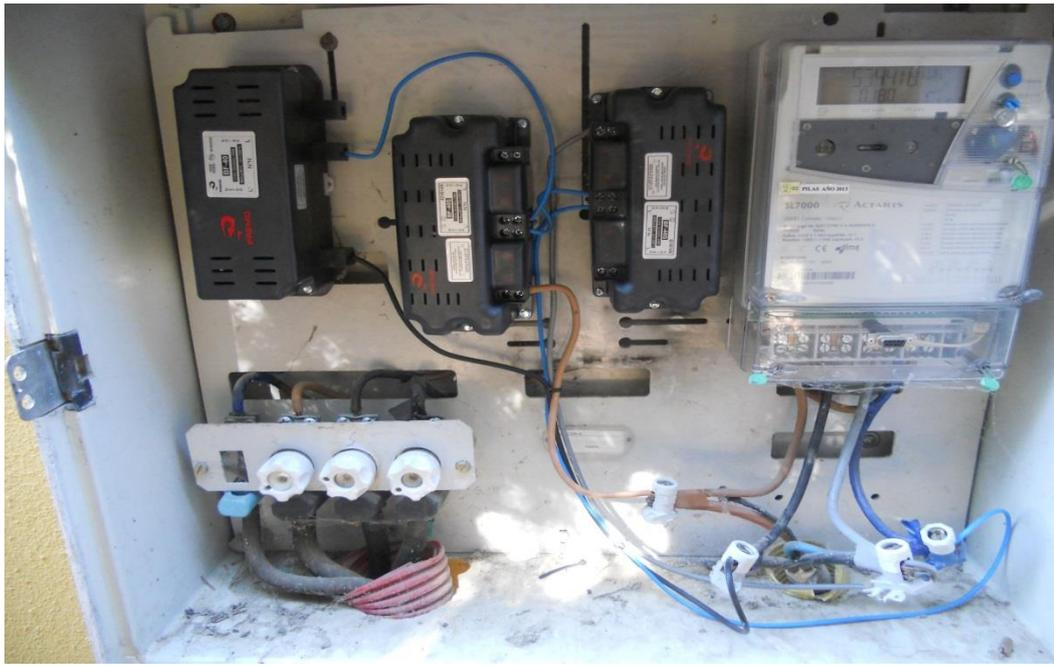
Figura 60. Filtros colocados en paralelo dentro del cuadro general de protecciones.
