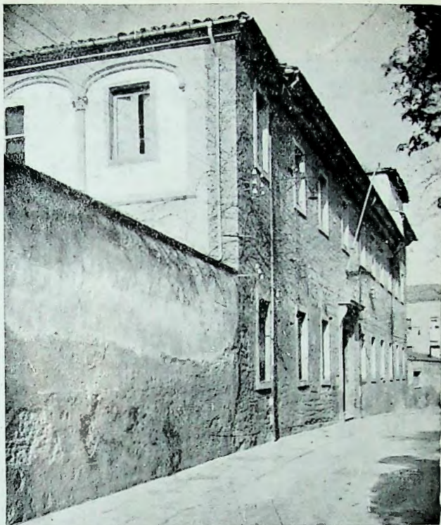
FOT. I. Fachada actual del lado Este.
