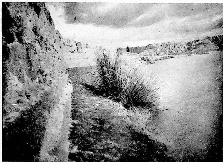
LÁMINA VIII. a) Tramo del dique con defensas «in situ» contra la corriente. b) Escalonamiento de muro de contención y trazado de los distintos lienzos.
