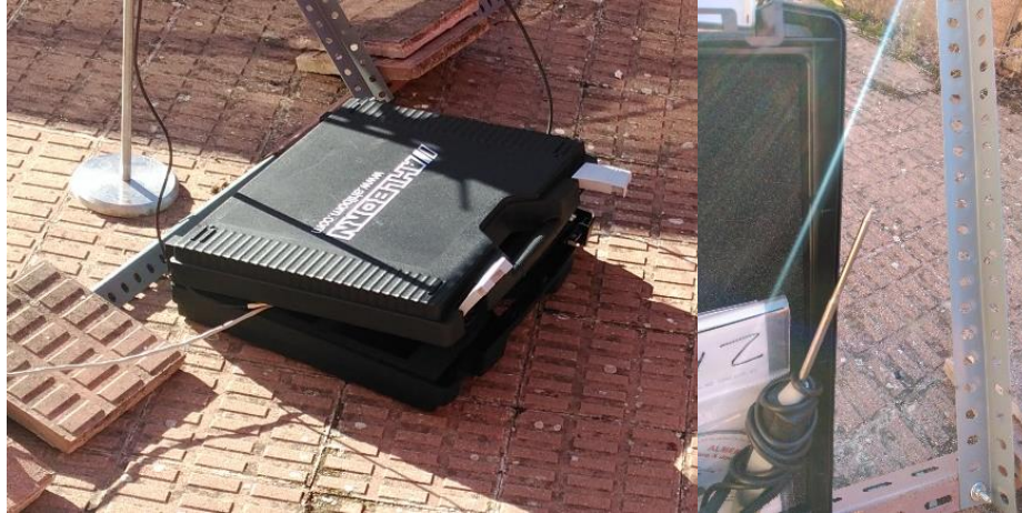
Figura III.3.2. 3 Situación sonda temperatura ambiente
