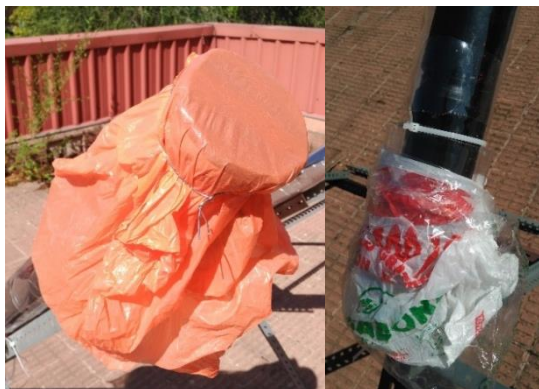
Figura III.1.2. 19 Elementos auxiliares para protección interior del colector.
