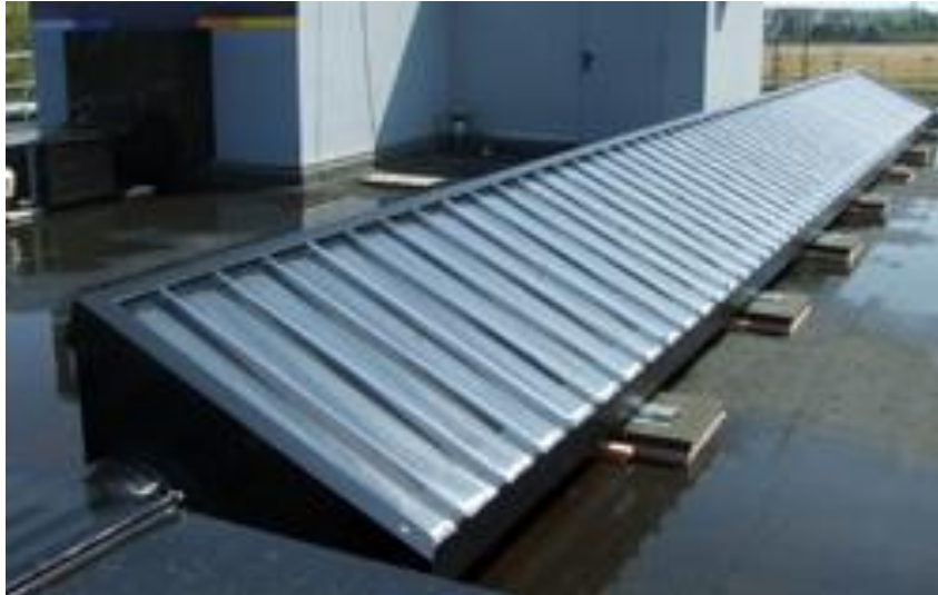
Figura II.2.2. 2 Sistema colector Solar Duct. Fuente: Solar Wall.
