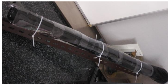
Figura III.1.2. 15 Colector unido a listón de estructura con bridas.
