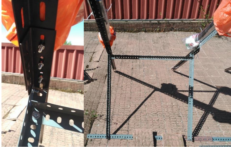
Figura III.1.2. 16 Unión de los colectores con la estructura.
