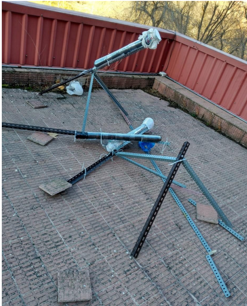
Figura IV.2.1. 14 Resultado de exposición a temporal atmosférico con fuertes vientos y precipitaciones.
