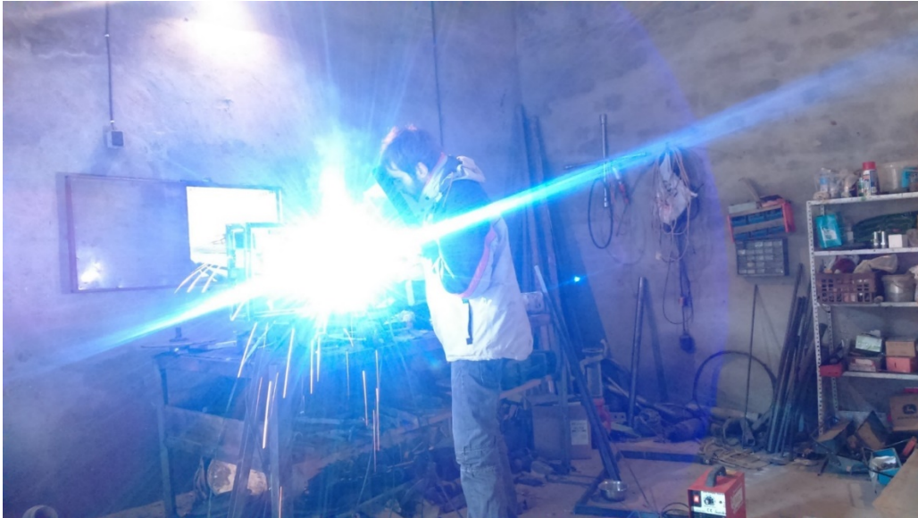
Figura 3.19: Construcción del prototipo
