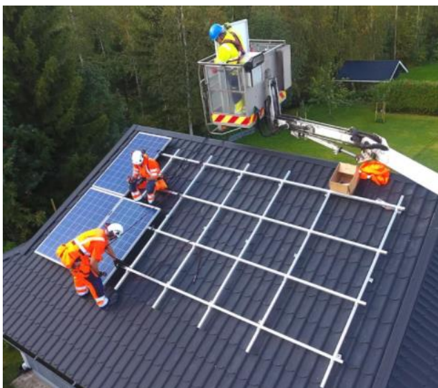
PICTURE 19. Installation of solar collectors ( https://yle.fi/uutiset/3-9831045 )
