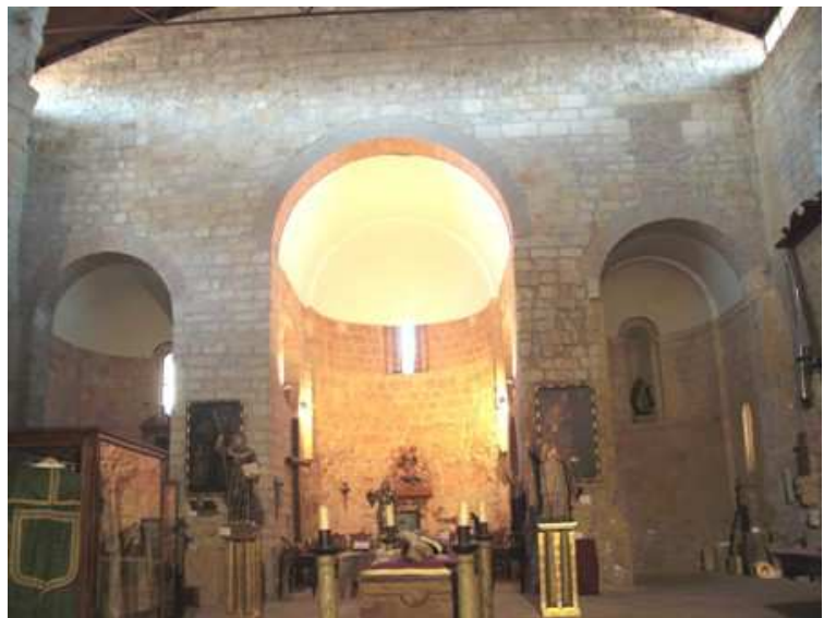
Estado actual de la capilla mayor de Santiag
