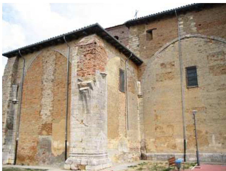
Vista del muro occidental con las arquerías góticas y los arranques de los arcos que señalan la prolongación del templo hacia el río.
