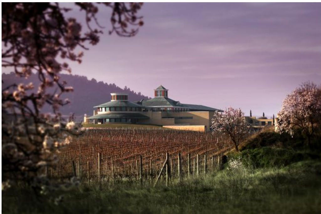
Figura 3.5 Bodega Dinastía Vivanco
