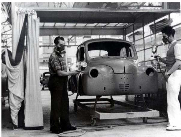
Figura 2.1. Primer Renault fabricado en España (Fuente: Renault, 2018)
