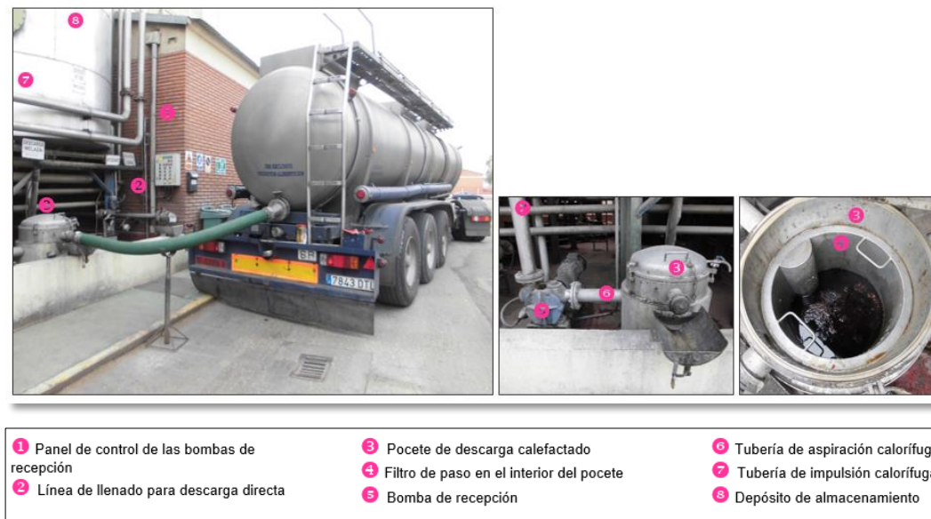
Figura 1: Descripción de los equipos utilizados para realizar la recepción de materias líquidas.
