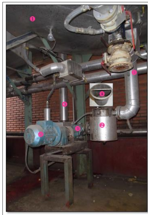
Figura 2: Descripción de los equipos utilizados para el pesado de las materias primas líquidas.
