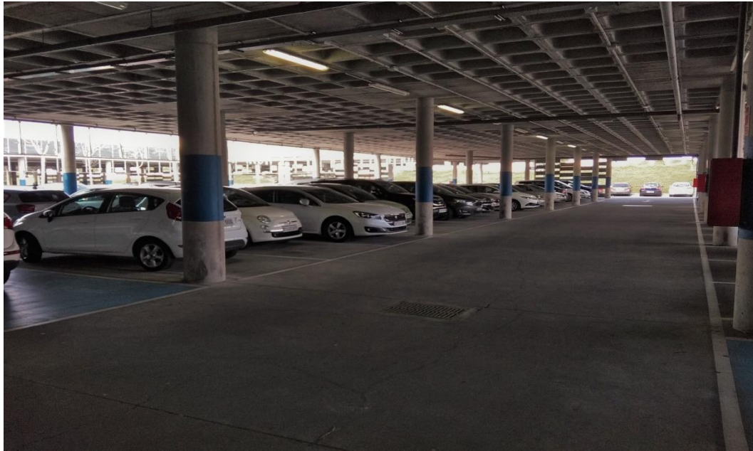
Fig. 1.3.- Situación de un pasillo del parking.
