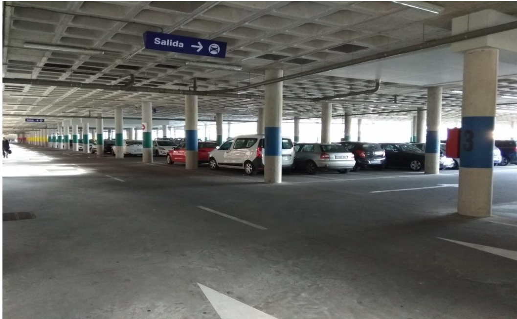
Fig. 1.4.- Situación interior del parking.
