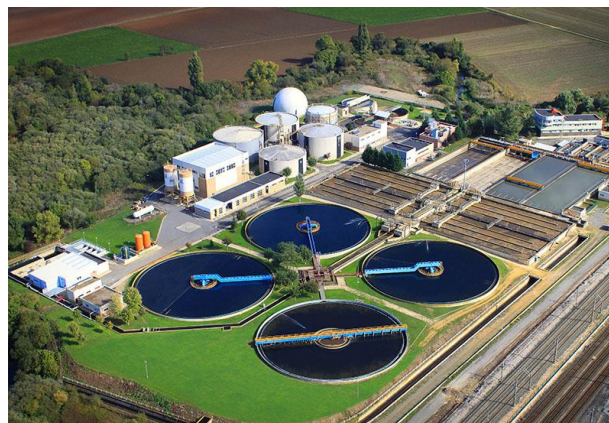
Figura 3.1. Estación depuradora de aguas residuales de Vitoria
