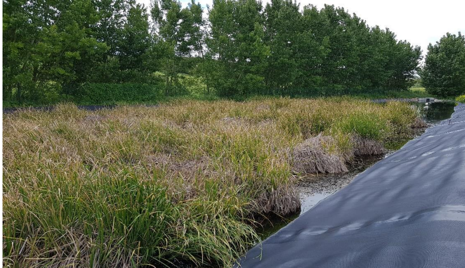
Foto 2: Humedal de Macrófitas en Flotación, EDAR Villanubla. Rodrigo de la Fuente, 2018.
