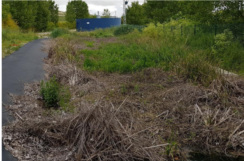
Foto 6: 1 er Humedal EDAR Villanubla, en malas condiciones debido a un mal manejo, no se retiró la biomasa ni se hicieron trat. Fitosanitarios de control, Rodrigo de la Fuente, 2018.
