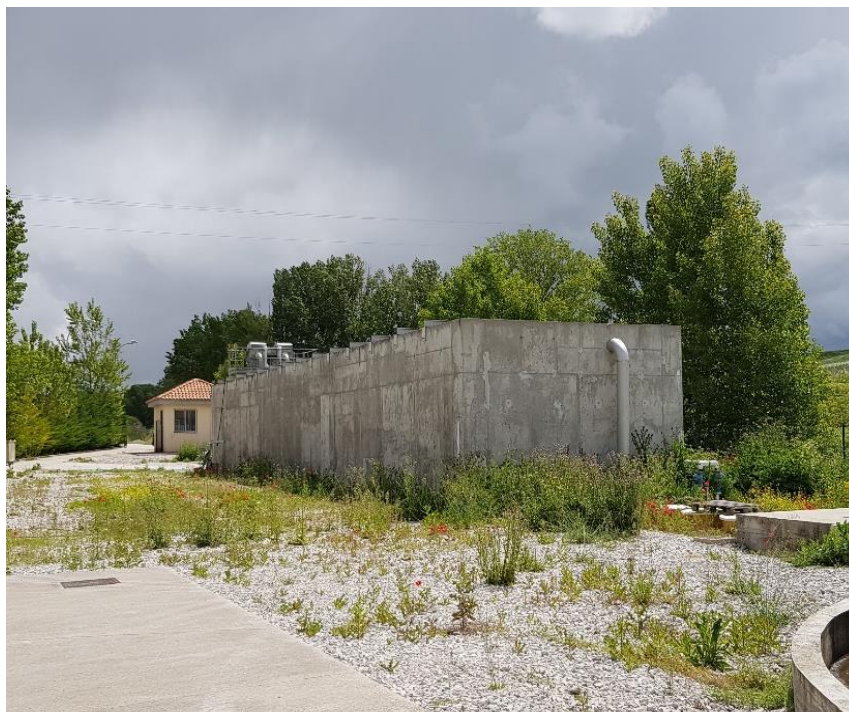
Foto 3: Decantador Emscher de EDAR Villanubla. Rodrigo de la Fuente, 2018.
