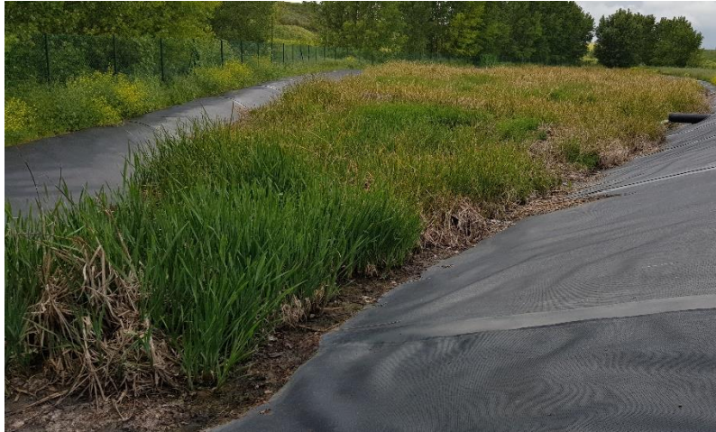
Foto 1: Humedal macrófitas en flotación, EDAR Villanubla. Rodrigo de la Fuente, 2018.
