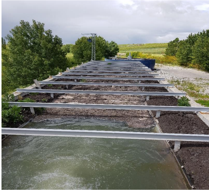
Foto 4: Superficie de Decantador Emscher de EDAR Villanubla. Rodrigo de la Fuente, 2018
