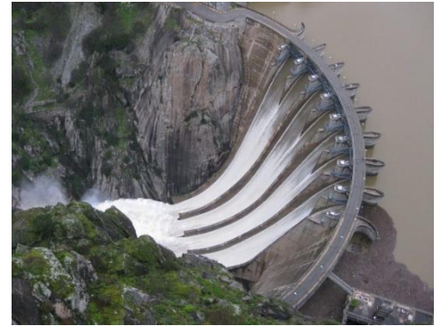
Figura 21: Presa de la central Valdeadávila
