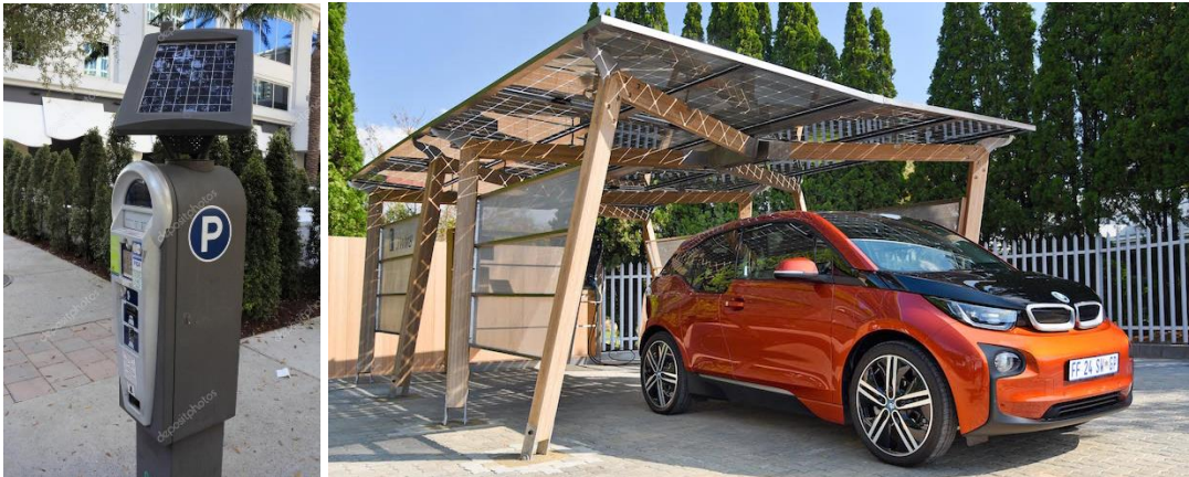
Figura 56: Ejemplos de instalaciones fotovoltaicas aisladas. Parquímetro y gasolinera solar.
