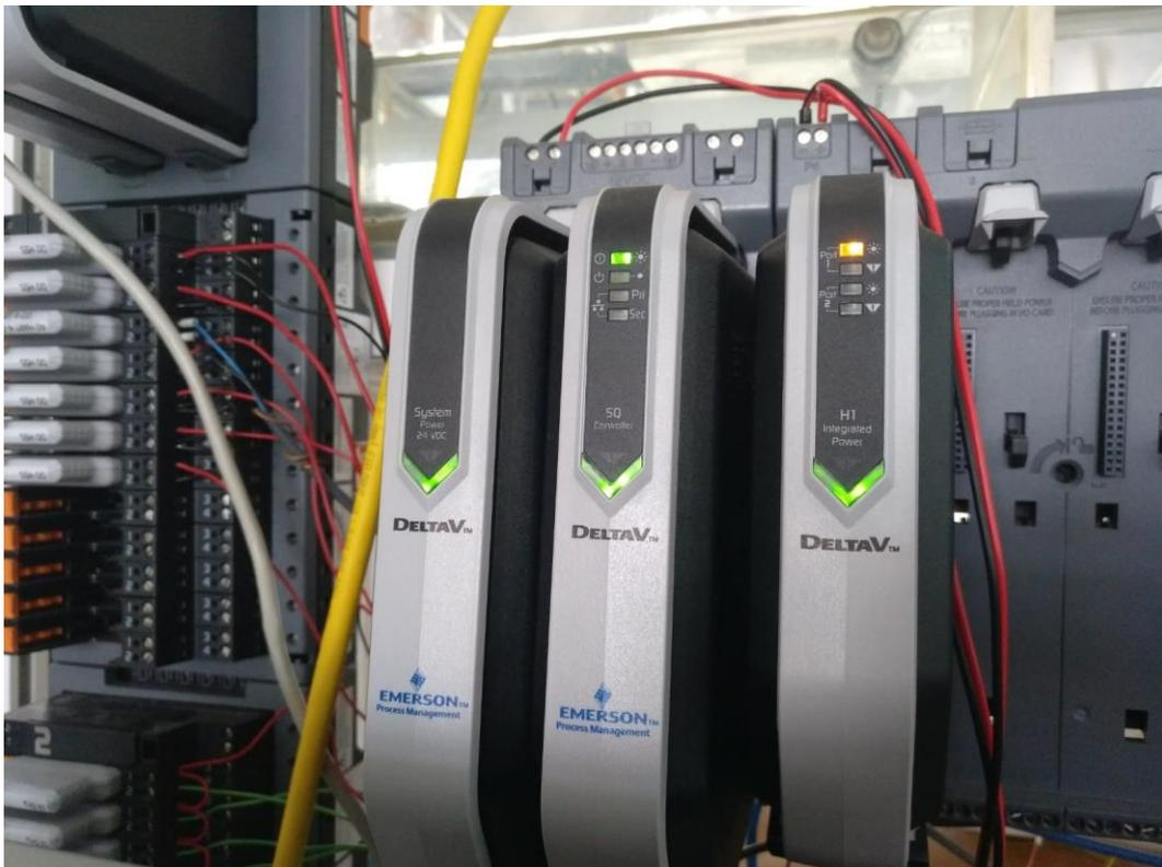
Figura 17: Fuente de alimentación, controlador y H1 Integrated Power
