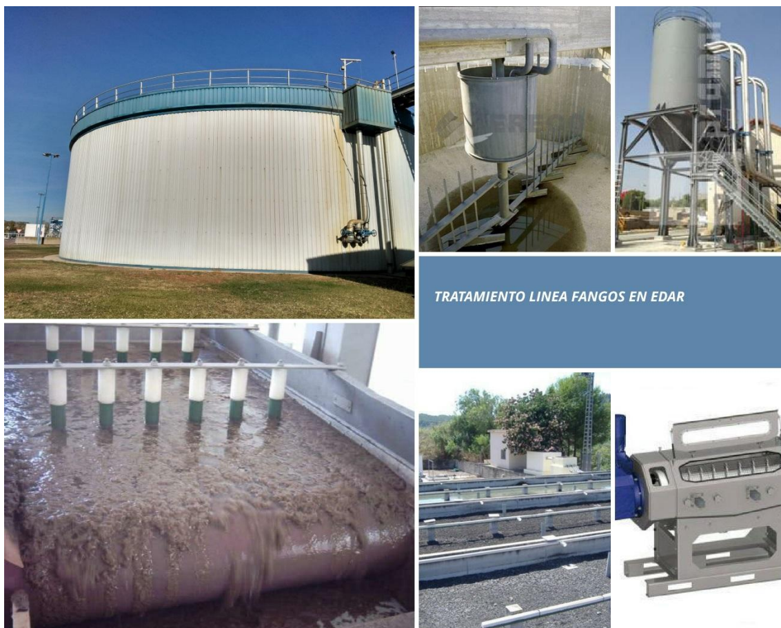
Figura 6. Tratamiento línea de lodos. Elaboración propia. Fotos EDAR Valladolid.
