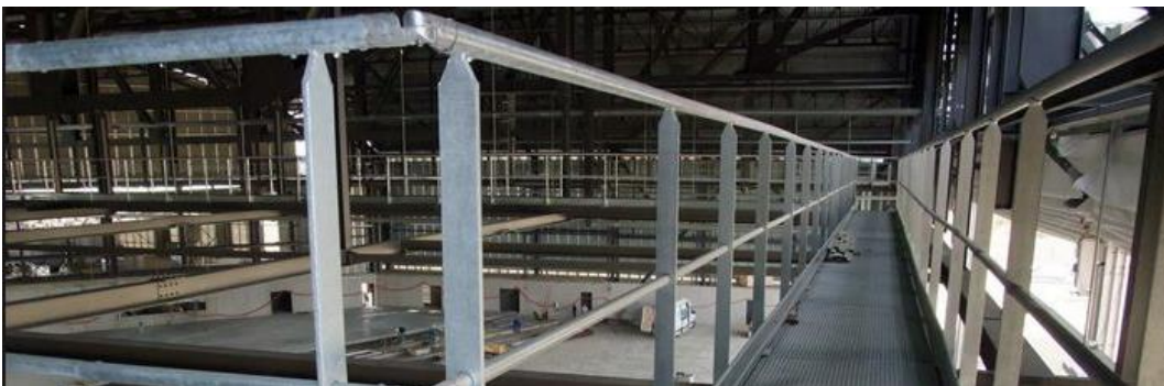
Figura 28: Pasarela con barandillas
